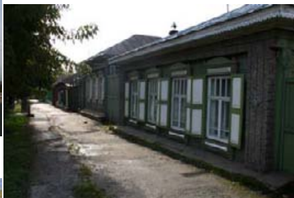
Tiument, jak wiele miast syberyjskich i tu fundament to wieczna zmarzlina. Stąd zapadające się z czasem domy
