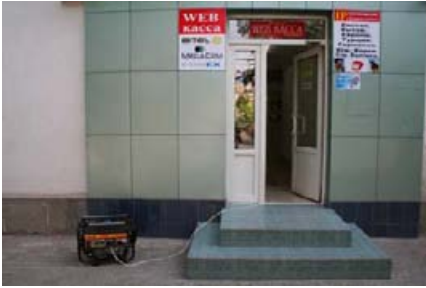
Przerwy w dostawie prądu, są tu codziennością. Generator zapewnia w miarę normalne funkcjonowanie
