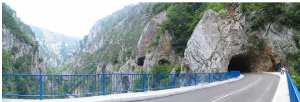
Tunele i most nad kanionem Pivą
